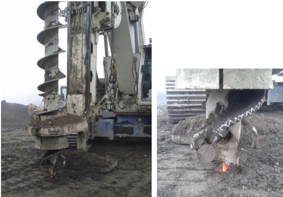
6.1. kép: a CFA fúrószár pontra állítása és csapóajtós vége
