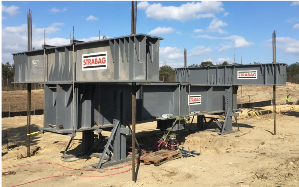
8.1. kép: 4 lehorgonyzó cölöpös nyomóterheléses statikus próbaterhelés
