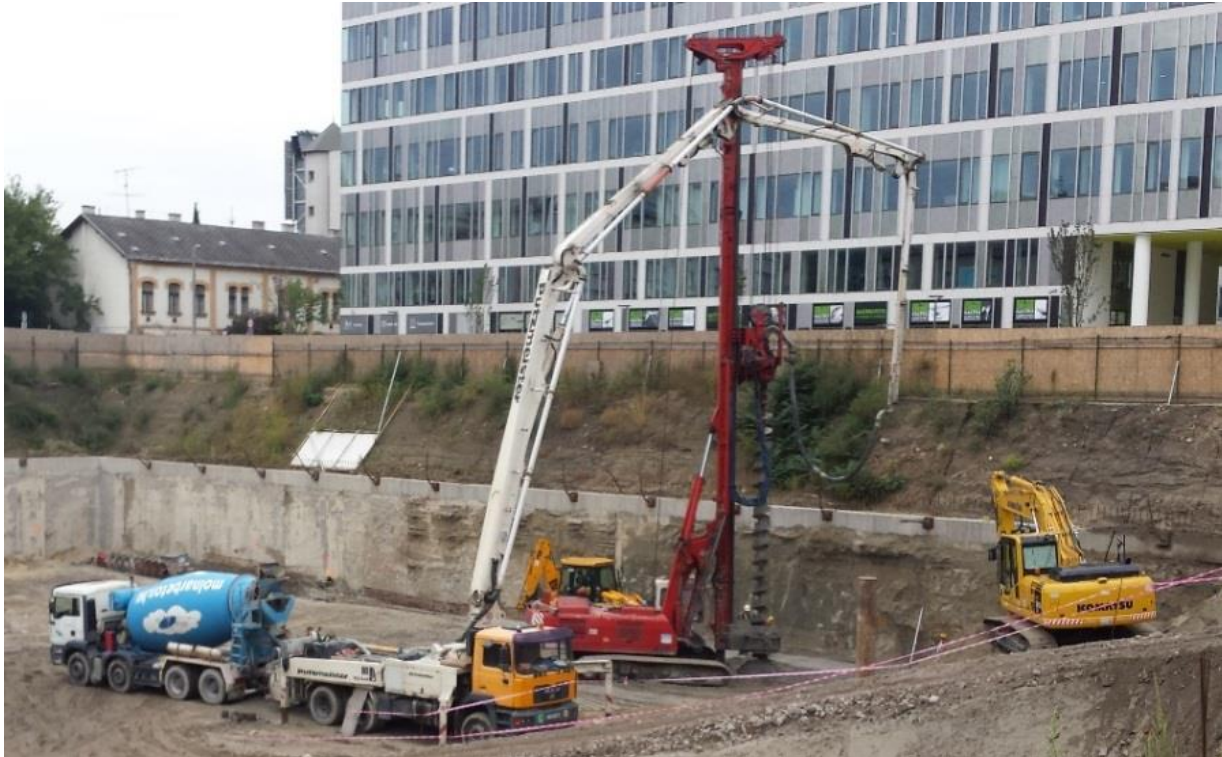
6.2. kép: CFA cölöp betonozása
