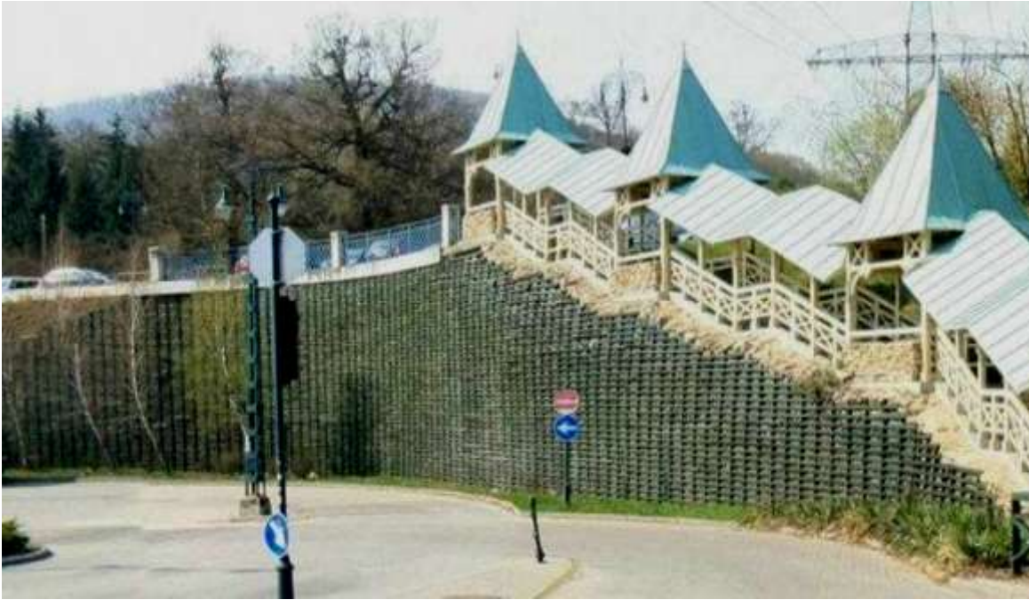
3.4. kép: Fa máglyafal a Hűvösvölgyi úton (Permacrib)
