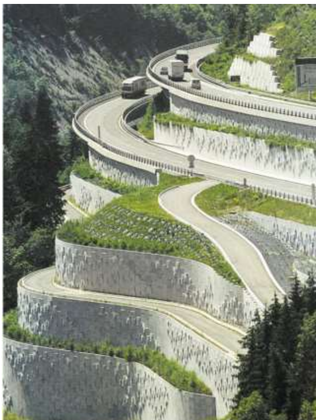
3.6. kép: Vasalt talajtámfalas töltés – TAI, Franciaország, A40 autópálya
