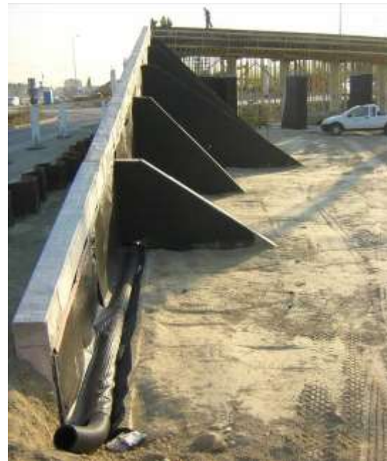
3.2. kép: Bordás szögtámfal híd-háttöltésben építés közben
