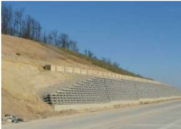
1.1. kép: M0 útgűrű - rézsústabilizálás
