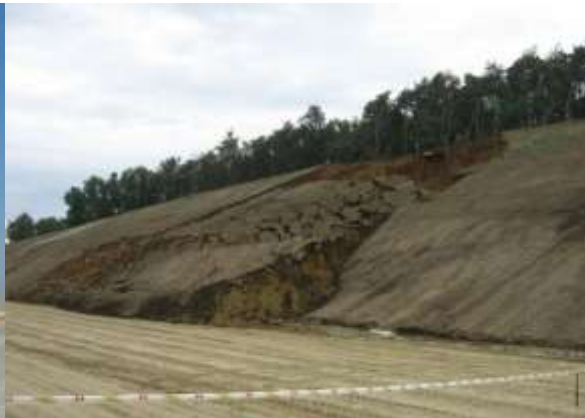
1.2. kép: M0 útgűrű - rézsúcsúszás
