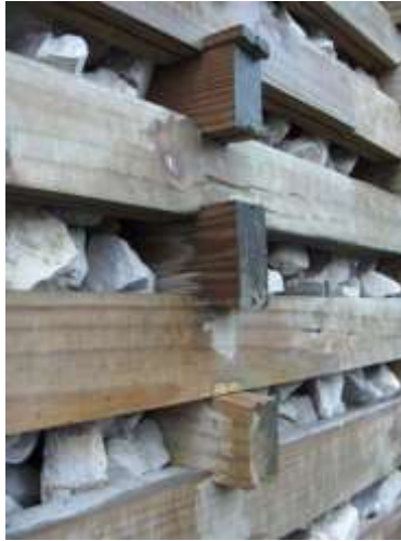
2.2. kép: Fa máglyafal - károsodott kapcsolatok
