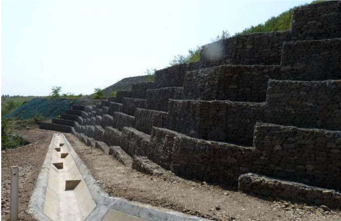
3.3. kép: Gabion támfal – GyöngyöSOROSZI ZAGYTÁROZÓ
