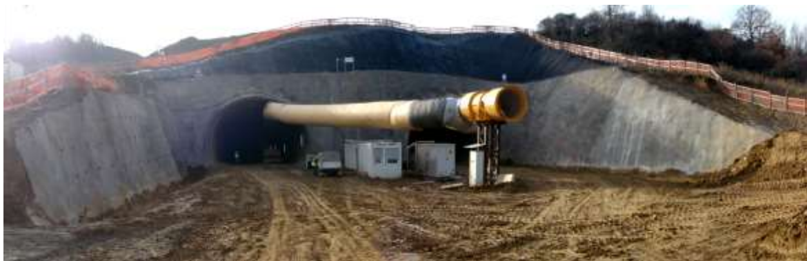
3.7. kép: Szegezett fal az M6-os autópálya A jelű alagútjának északi bejáratánál
