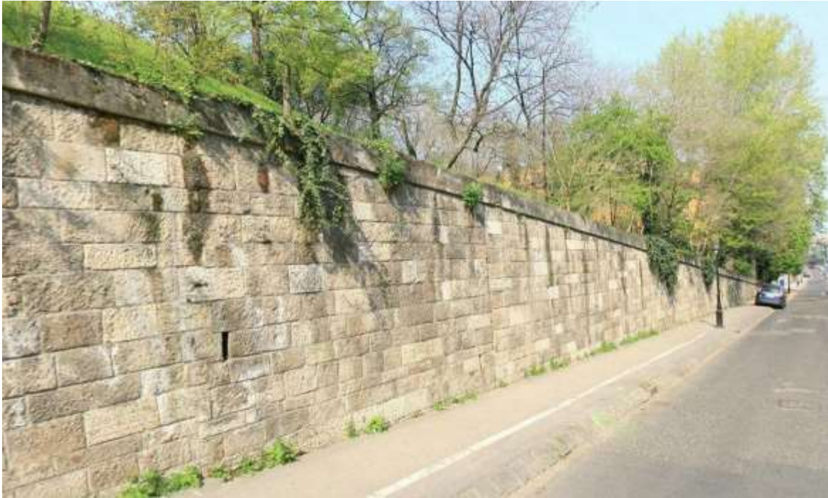
3.1. kép: Faragott kő burkolatú súlytámfal
