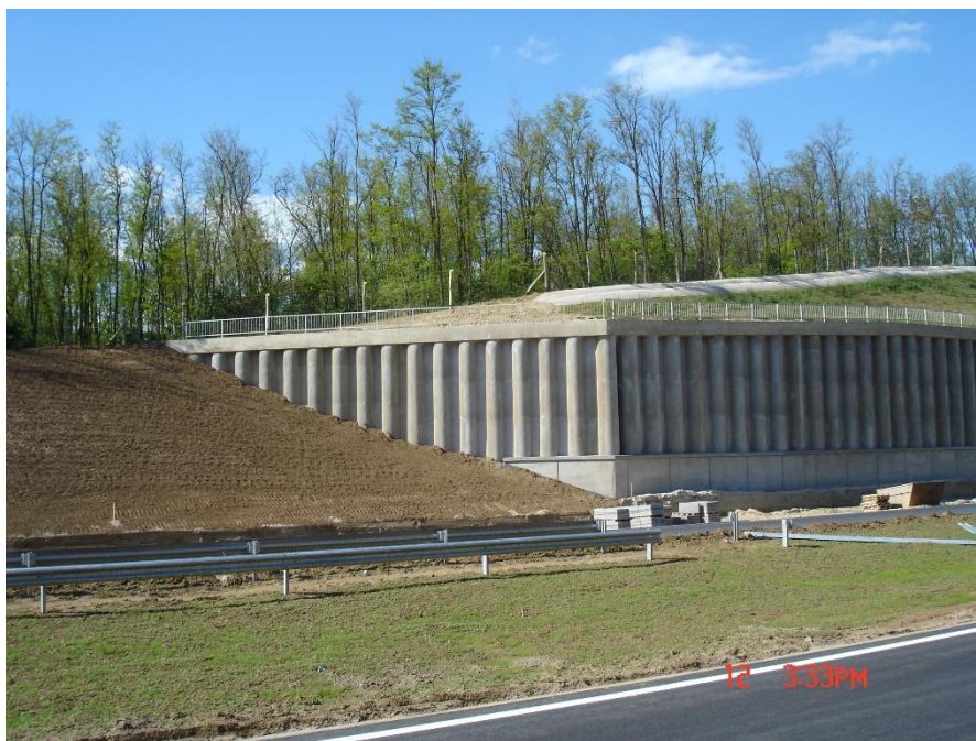
17. ábra: Cölöpfal hátsó cölöpsorhoz véglegesen hátrahorgonyozva
