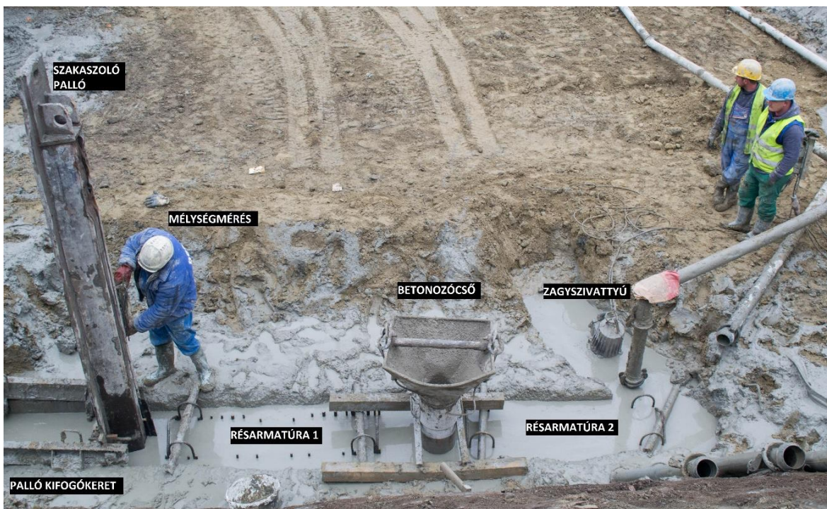
3. ábra: Réspanel kivitelezése
