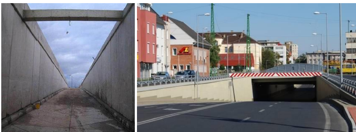
4. ábra: Előregyártott réspanel aluljáró és Győr, Nádor aluljáró - résfalas oldalhatárolás
