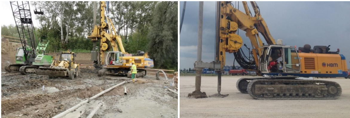
18. ábra: Egy elégtelen és egy ideális munkaplatform
