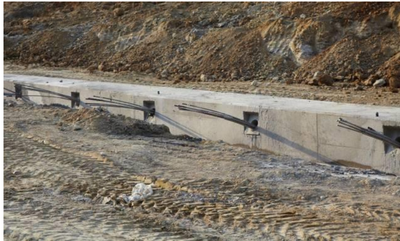
15. ábra: M0 útgyűrű - horgonyok előfeszítés előtt
