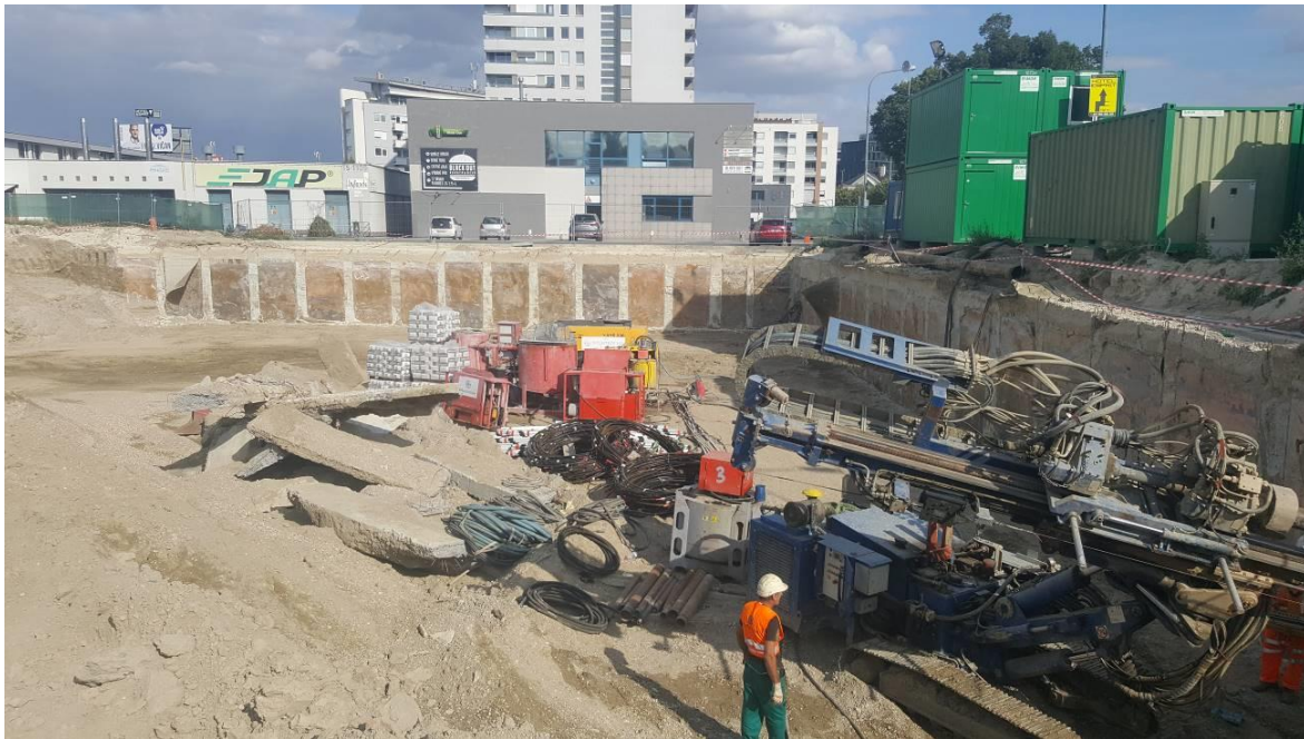
11. ábra: Erősített önszilárduló zagyfalas munkatérhatárolás kivitelezése az acél erősítőelemek közötti, vékony acéllemez felületvédelemmel
