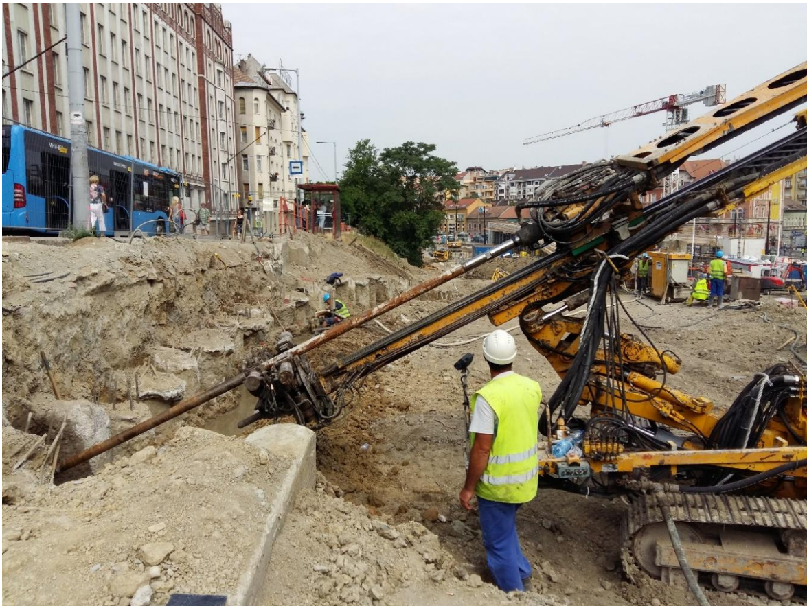
14. ábra: Hézagos cölöpfal horgonyzási munkái
