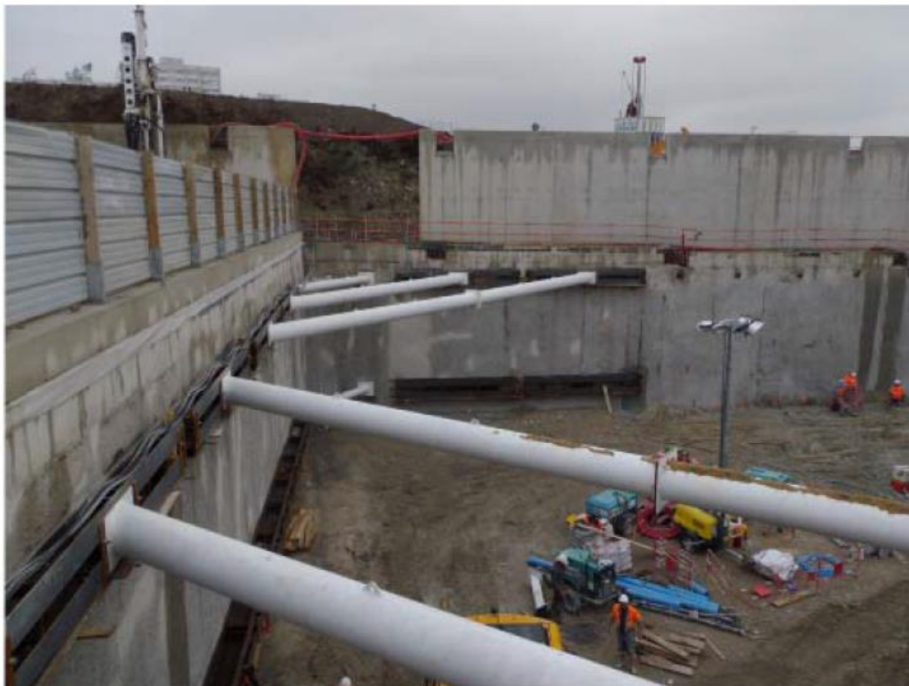
16. ábra: Mellgerendával ellátott, toldott acél sarokdúcok
