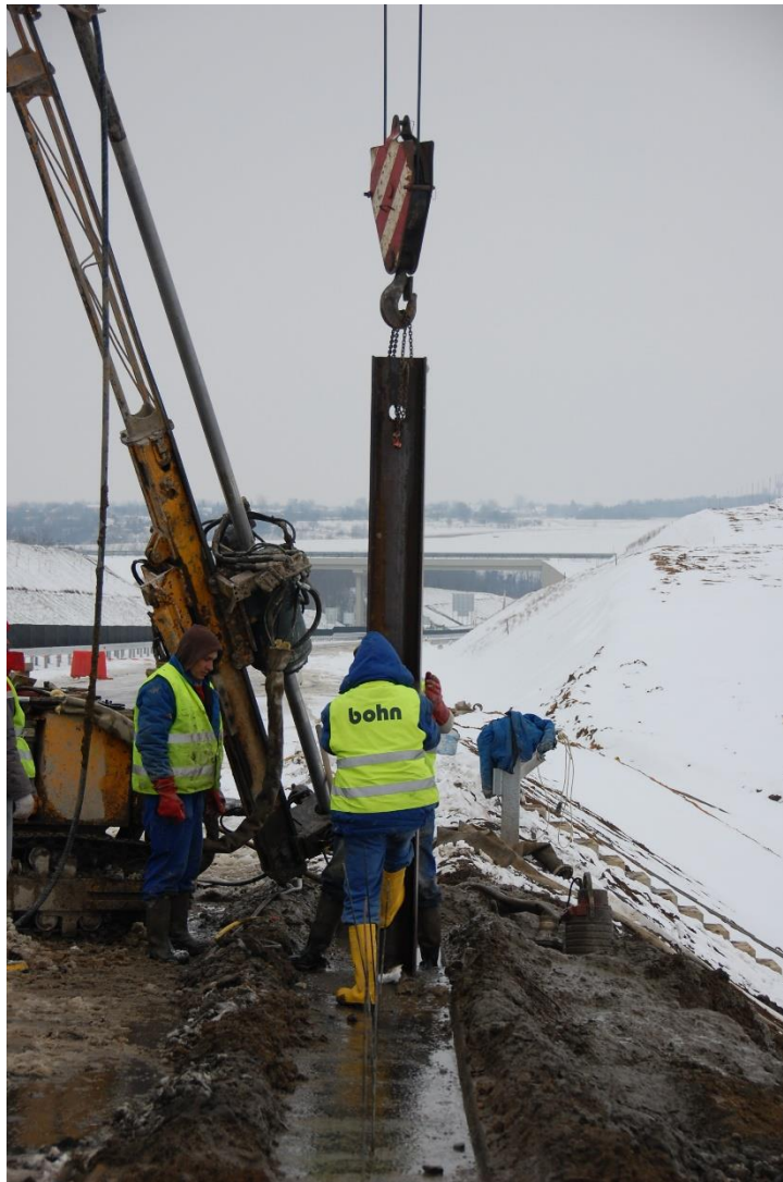
9. ábra: Acétag beemelése jet-grouting falba
