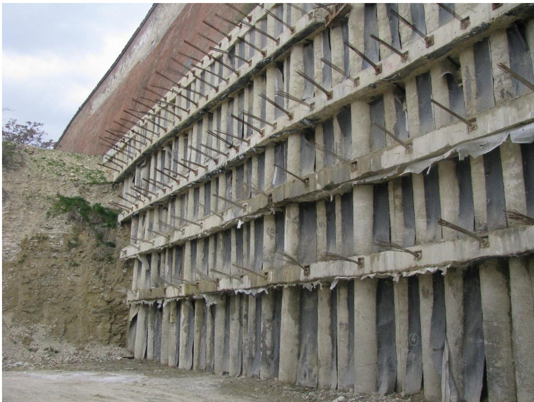
7. ábra: Cölöpfal 5 sorban, teherelosztó gerenda mentén kihorgonyozva
