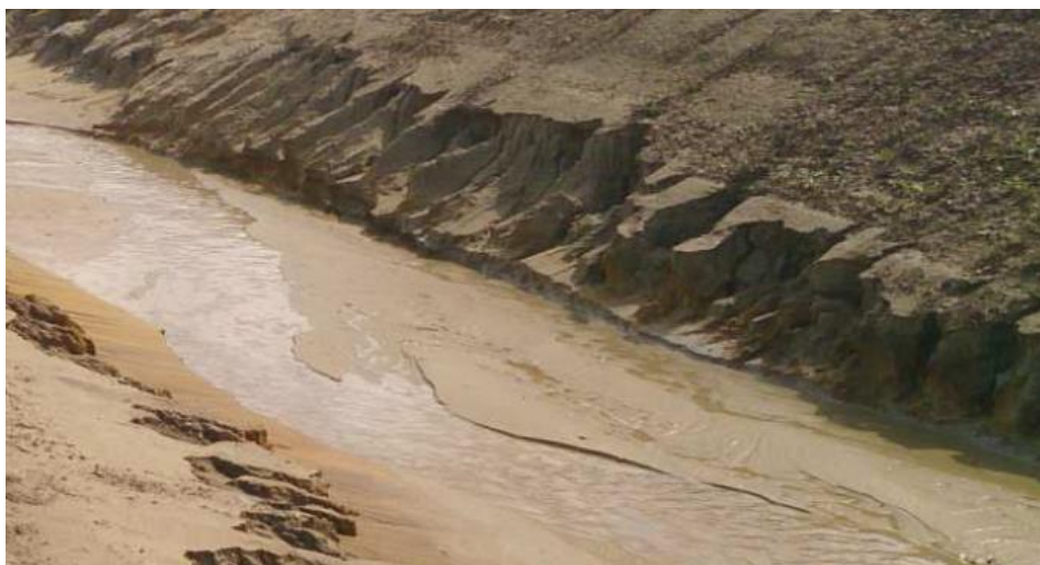
2.33. ábra. Talajvíz okozta rézsűkárosodás [Forrás: Szerzők]
