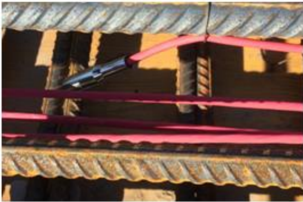
28. ábra. Alkalmazási példa - híd pályalemez kiegészítő hőmérséklet mérése (forrás: A-Híd Zrt.)
