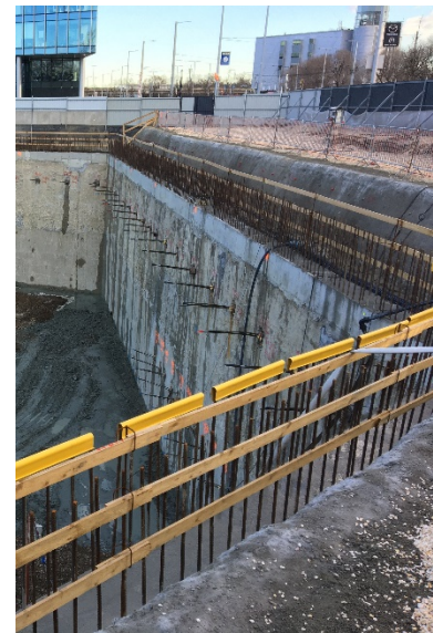
12. ábra: Résfal-alaplemez kapcsolat (bal) és résfal felső kitüskézése (jobb)
