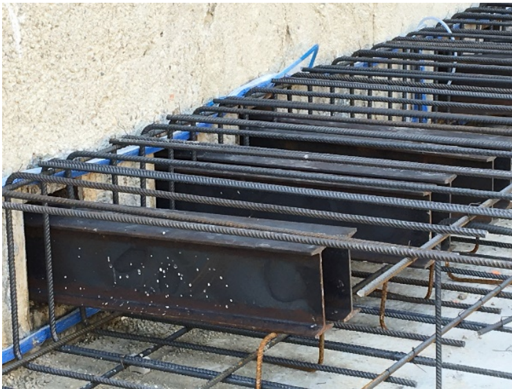
12. ábra: Résfal-alaplemez kapcsolat (bal) és résfal felső kitüskézése (jobb)
