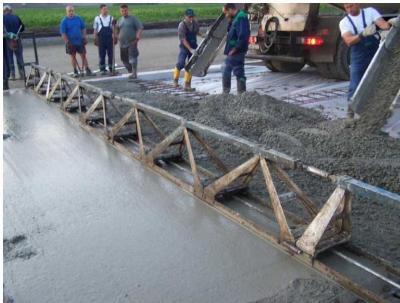
20. fénykép: Kültéren készülő padló betonozása
