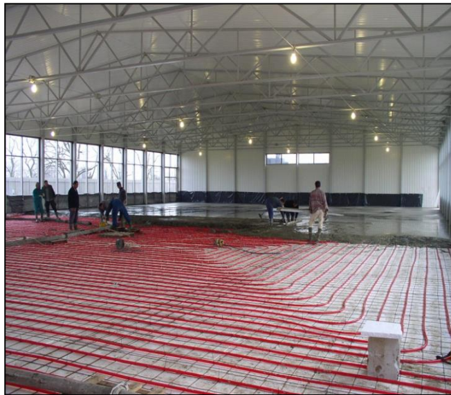
5. fénykép: Padlófűtési ipari padló, ablakgyár – Budapest (forrás: Betonmix)
