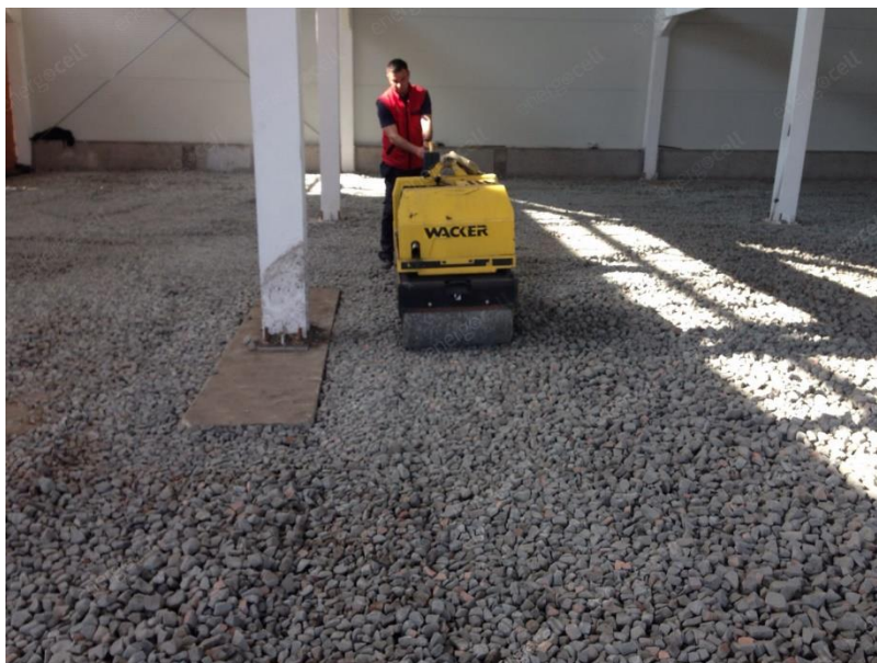
15. fénykép: Üveghab hőszigetelés ipari padlóknál (forrás: www.energocell.hu )
