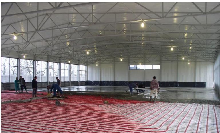
14. fénykép: Polisztirol hőszigetelés ipari padlóknál ( www.betonujsag.hu )
