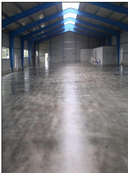
1. fénykép: Vágott fugás, normál (standard) ipari padló - Ipari csarnok, Tököl (forrás: Betonmix)
