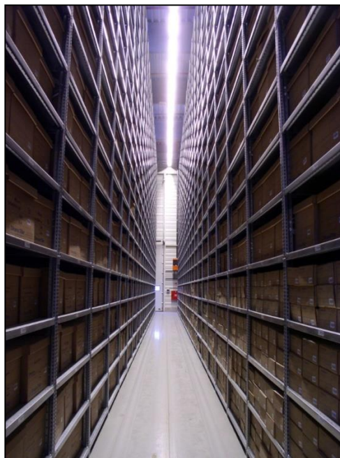
3.fénykép: Nagy síkpontosságú (superflat), szűkfolyosós ipari padló - Raktár csarnok, Szigethalom (forrás: Betonmix)
