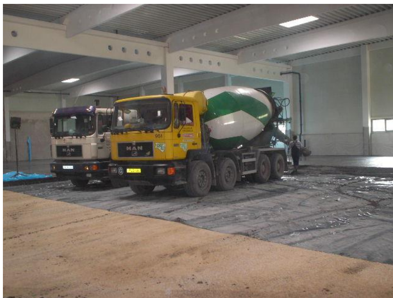
22. fénykép: Betonmixerekből surrantóval betonozzák az ipari padlót
