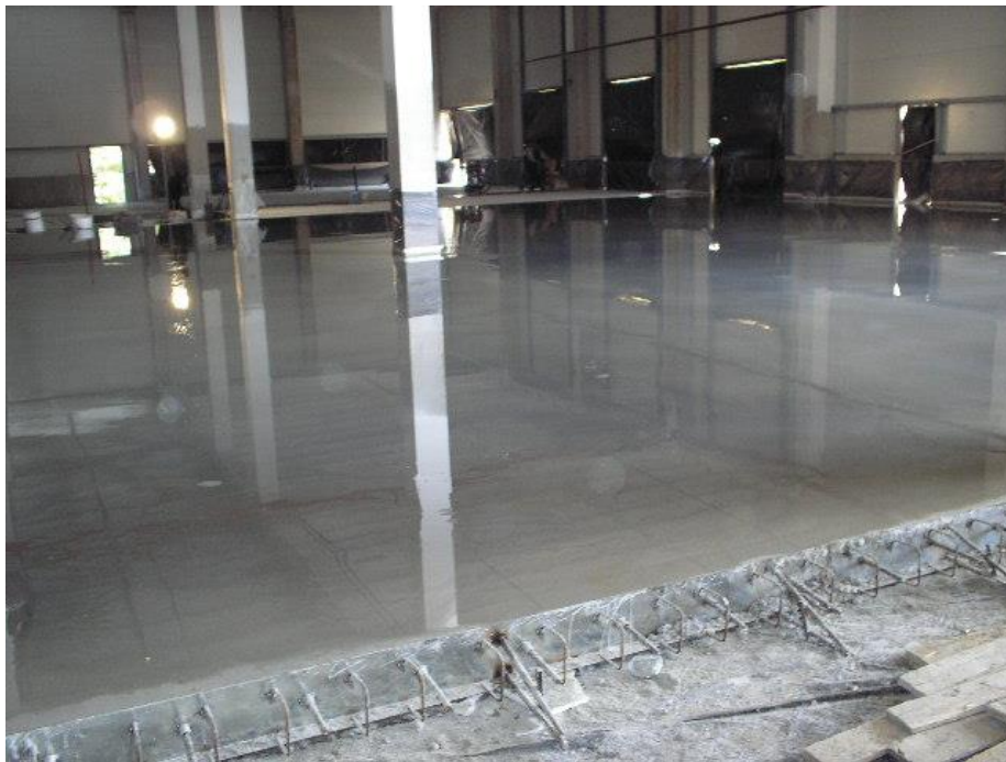
19. fénykép: Elkészült ipari padló betonja
