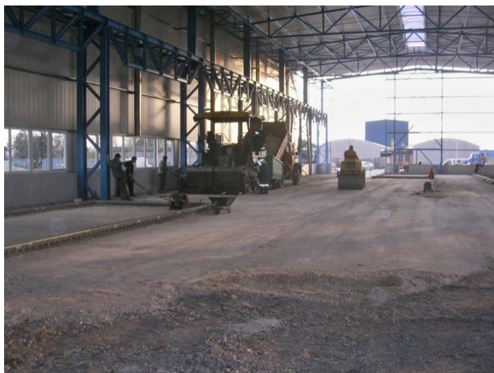
18. fénykép: Ipari padló alatti ágyazat beépítése
