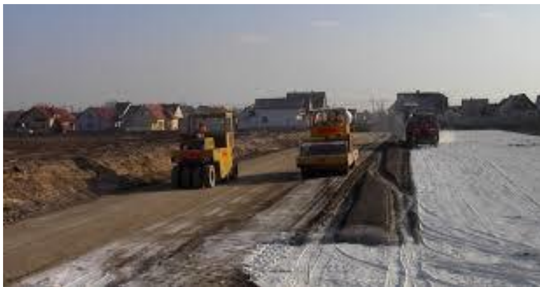
13. fénykép: Meszes talajstabilizáció (forrás: www.inreco.hu )
