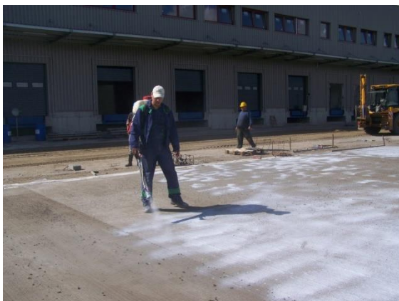
28. fénykép: Beton utókezelése párazáró szóróanyaggal vagy fólia takarással
