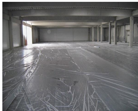
28. fénykép: Beton utókezelése párazáró szóróanyaggal vagy fólia takarással
