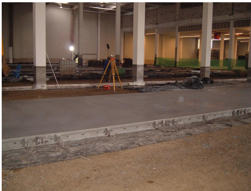
24. fénykép: Formasínek alkalmazása a betonozási munkákhoz
