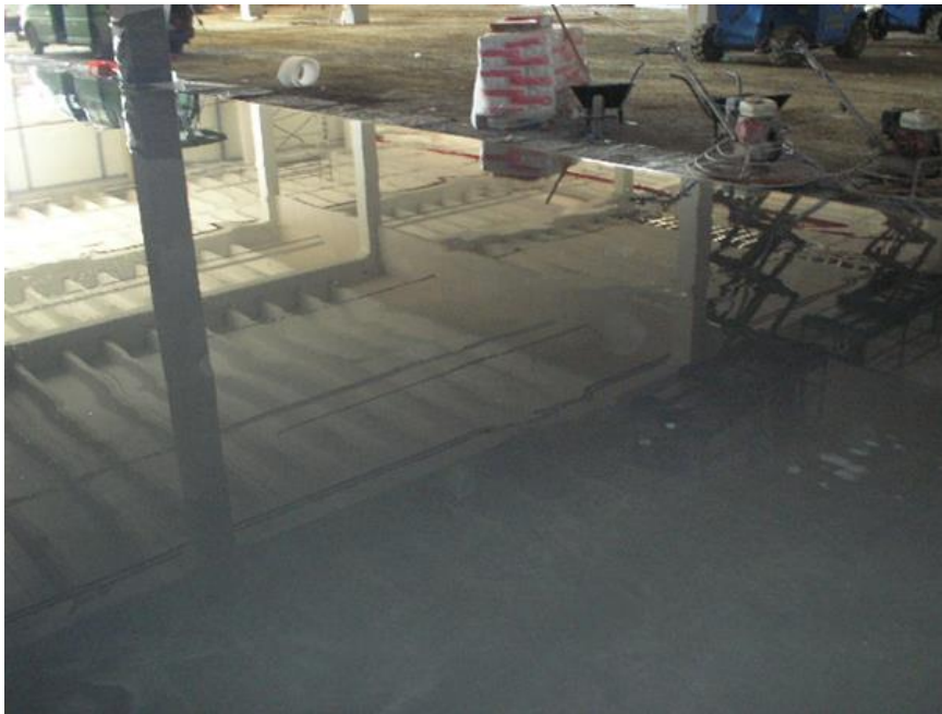
27. fénykép: Beton utókezelése vízzel való elárasztással
