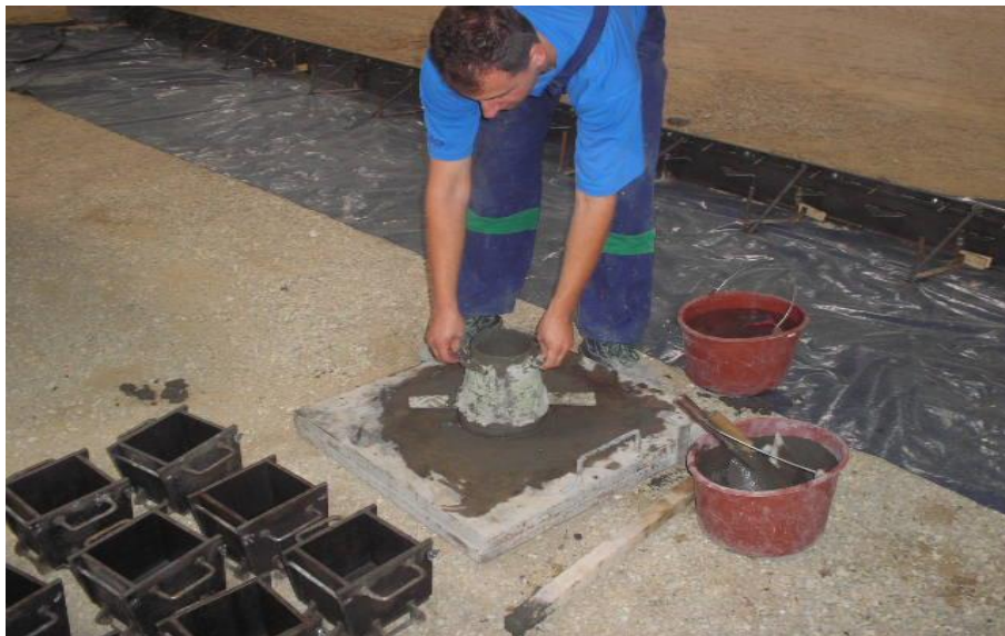
21. fénykép: Betonozás során végzett terület mérés
