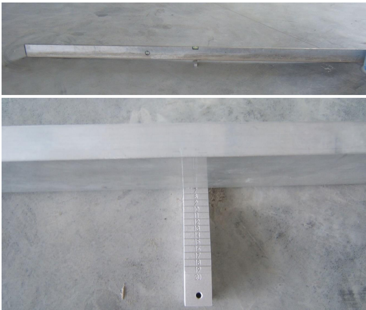
8. fénykép: Síkpontosság mérése (forrás: Betonmix)
